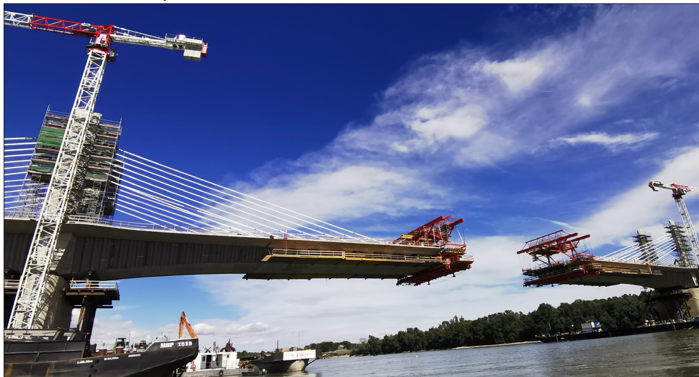
1. ábra: Szabadszerelés a medernyílásban
