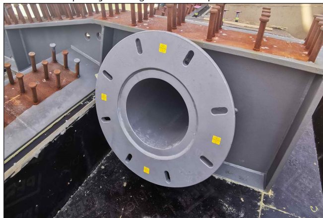
12. ábra: Kalapácsfej karima geodéziai mérőpontok
