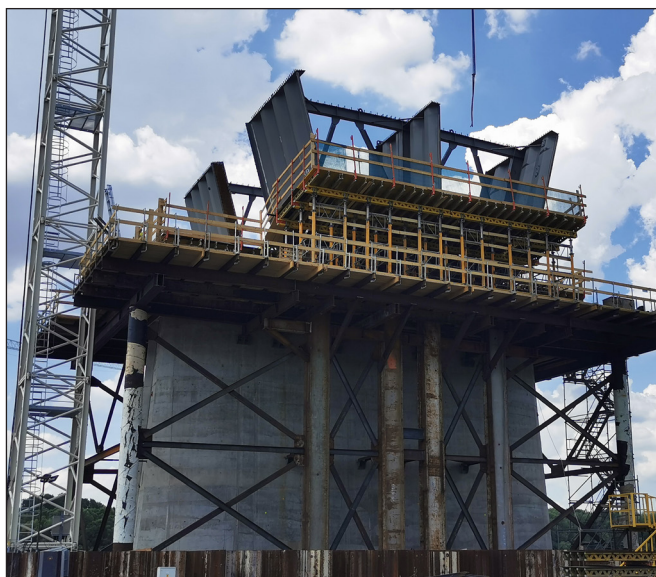
2. ábra: Indítózöm és segédszerkezete a mederpilléren
