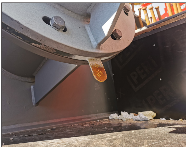
13. ábra: Függőlegesen felfelé korrigáló éklemesz
