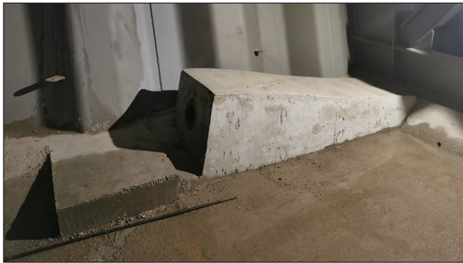
8. ábra: Csúszóbetétes kábel lehorgonyzó tömb
