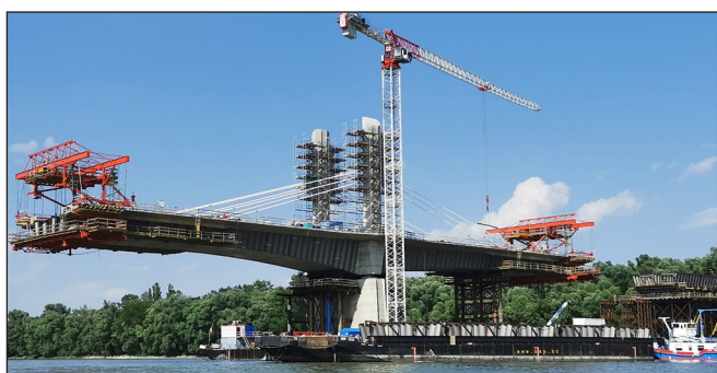
3. ábra: Segédszerkezetek a kalocsai oldalon
