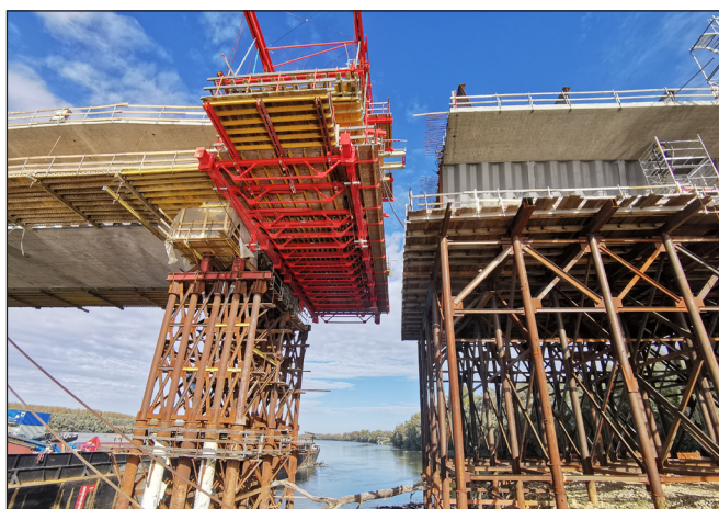
4. ábra: SJ2 járom és P24-P20 alatti állványzat, parti zárás előtt 1 zömmel
