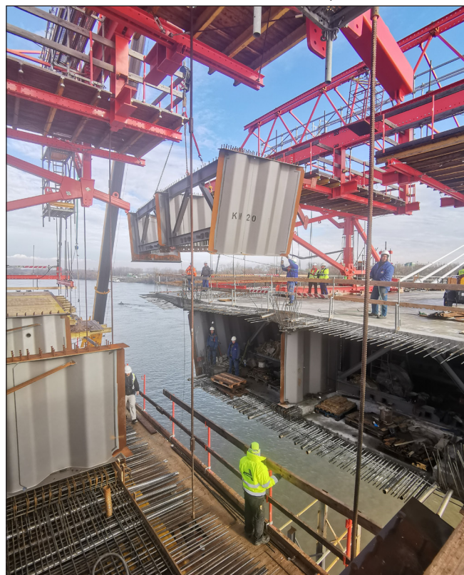
9. ábra: MM20 zárózom beemelése a mederközépen
